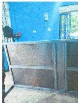
Foto 3: Fabricación e instalación de puertas de metal en módulos
