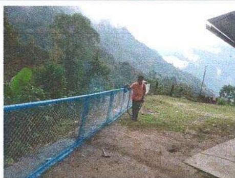
Foto 8: Reparación de tubo hg y malla galvanizada
