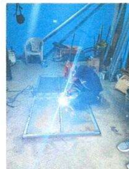
Foto 4: Fabricación de puerta de metal en baños
